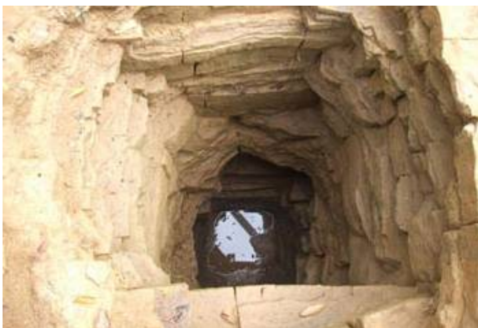
Sl.30 Šaht- Bunar na platou piramide Mjeseca. Iskopan ručno 5,0 m. Poslije toga bušeno u istom šahtu sa bušačom garniturom prečnika 116 mm do dubine 20,2 m. Sve je bio tvrdi pješčar u kamenim žutim blokovima, naslaganim u slojevima, jedan iznad drugog (Photo: Arhiv Fondacije, oktobar 2006.)
