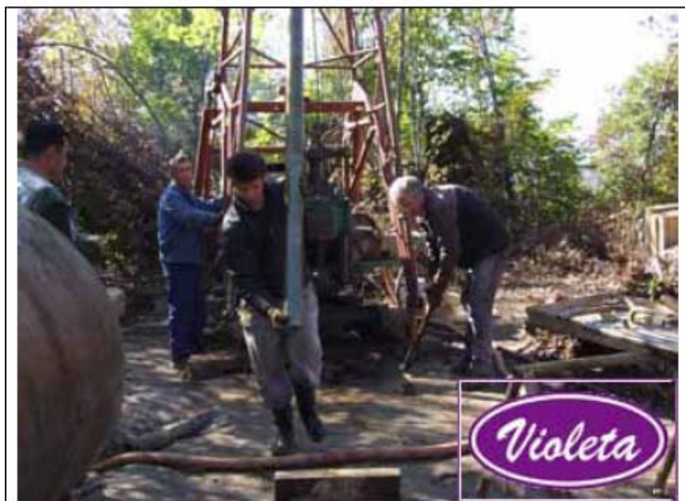
Sl.23 Istražno bušenje na platou piramide Mjeseca. Vađenje uzoraka iz bušotine B4 (Photo: Arhiv Fondacije AP BPS, novembar 2006)
